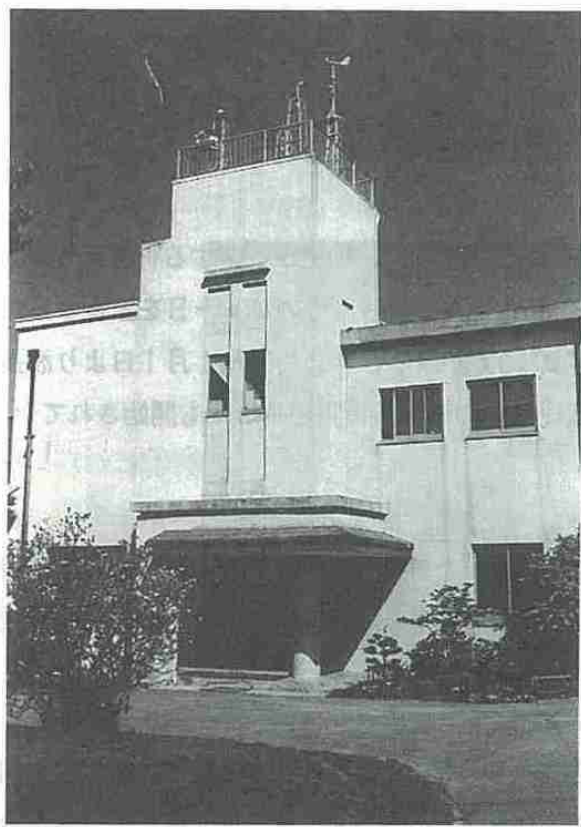
函館海洋気象台 現庁舎
