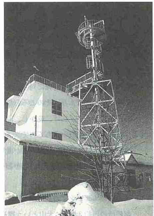
写真5 ノッポの測風塔と測風鉄塔
