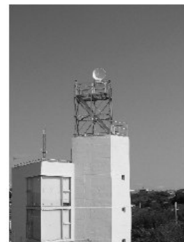
既存のタワーに仮設した例
