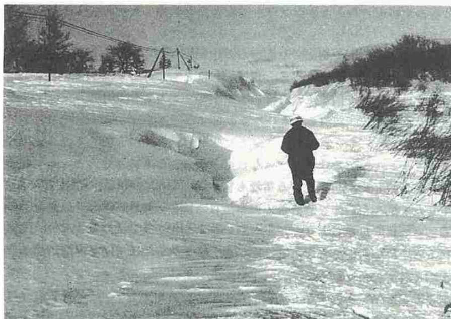
写真-1 吹きだまりに埋もれた道路
