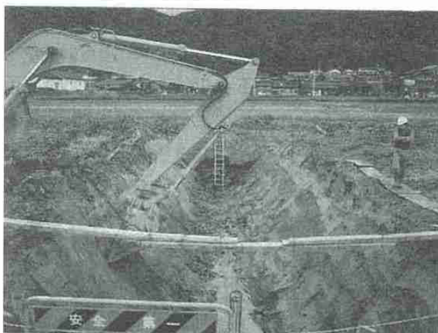
図5. 活断層の発掘調査の様子。断層を横切る大きな溝(トレンチ)を掘削し、斜面に現れる断層のずれを調べ、何回、いつ頃、どのくらい変位したかを調査し、断層の活動度を評価するために行われている。
